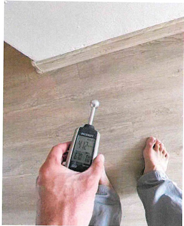
Spodní úroveň - Vlhkost 4%
