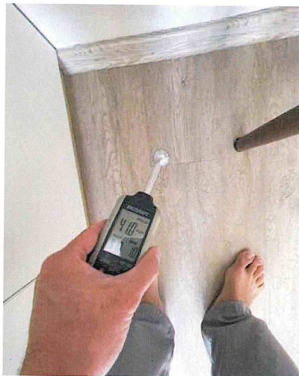
Spodní úroveň - Vlhkost 4%
