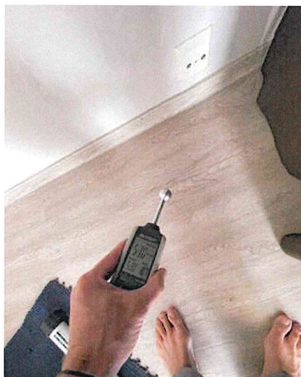
Spodní úroveň - Vlhkost 7%
