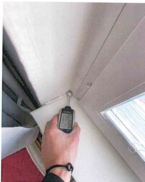
Spodní úroveň - Vlhkost 10%
