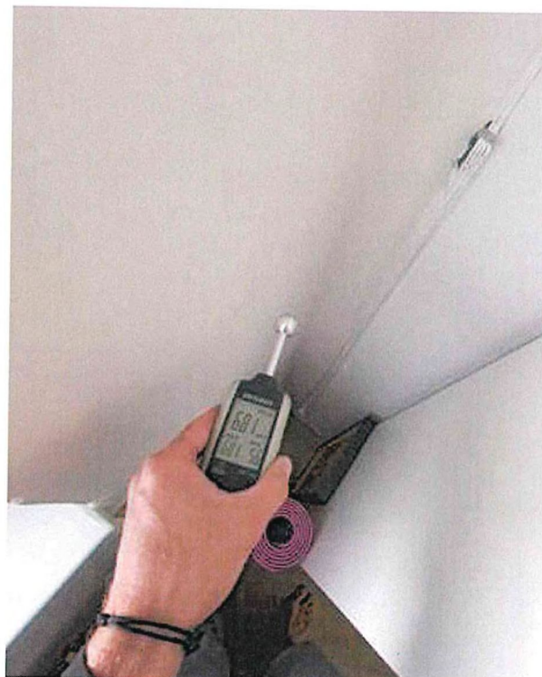
Spodní úroveň - Vlhkost 12%
