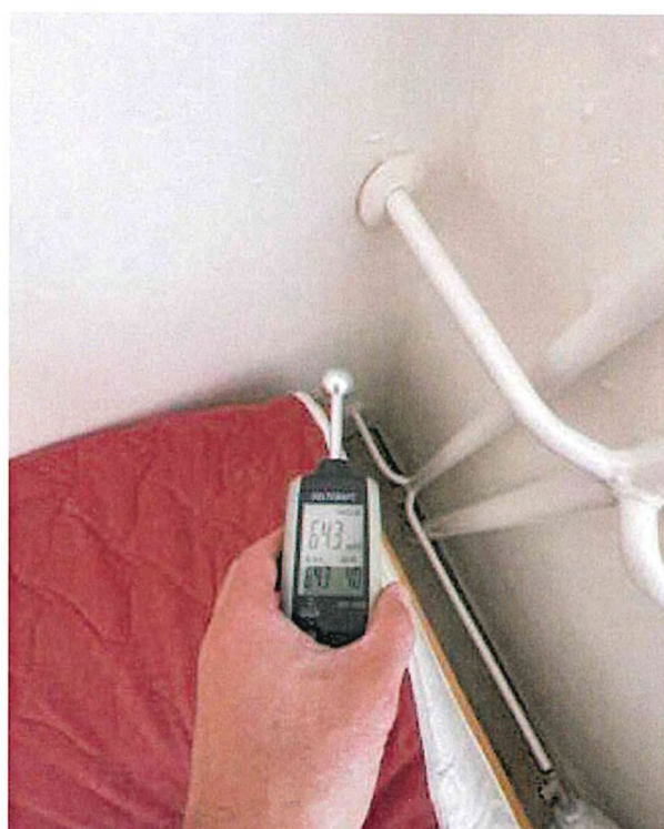
Spodní úroveň - Vlhkost 11%
