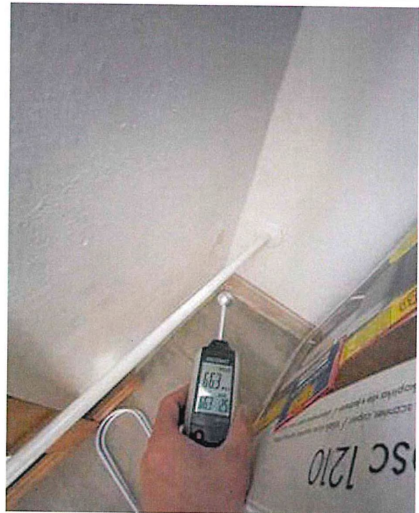
Spodní úroveň - Vlhkost 11%
