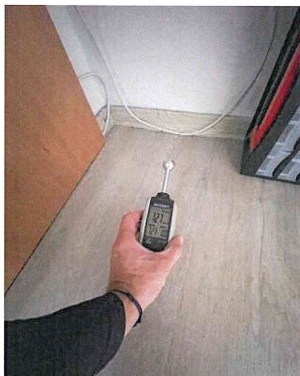
Spodní úroveň - Vlhkost 13%
